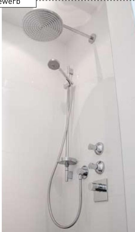
Die Dusche garantiert mit zwei Absperrventilen eine einfache, altersgerechte Handhabung.
